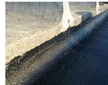
Рис. 2. Изоляция жидкой резиной стыка водосборного лотка и кровельных панелей.
