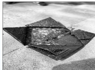
Рис. 1. Образование вздутий кровельного ковра (проблемное место).
