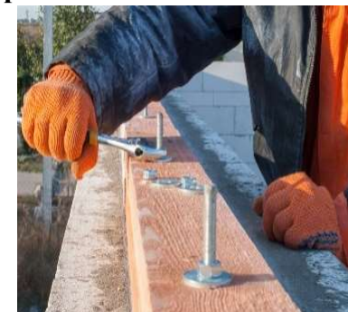
Крепление мауэрлата с помощью резьбовых шпилек .
