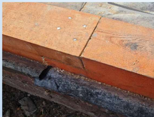
Соединение элементов лежня.
