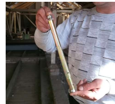
Крепление мауэрлата с помощью анкеров .
