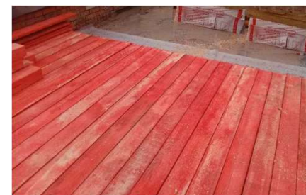
Устройство сплошного настила по утеплителю в чердачном помещении с деревянным перекрытием
