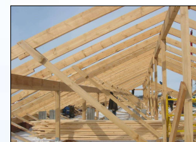
Стропильная система наслонного типа
