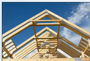
Стропильная система висячего типа
