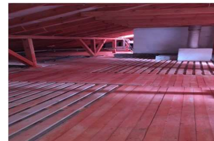
Устройство сплошного настила по утеплителю в чердачном помещении с железобетонным перекрытием
